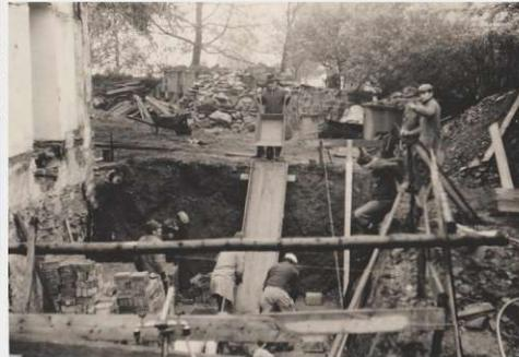
Das Fundament für den neuen Schornstein wird gemauert.
